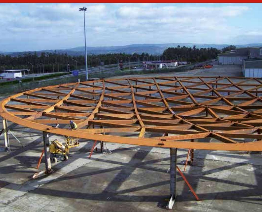
Test di assemblaggio della copertura della Place Rogier a Bruxelles
