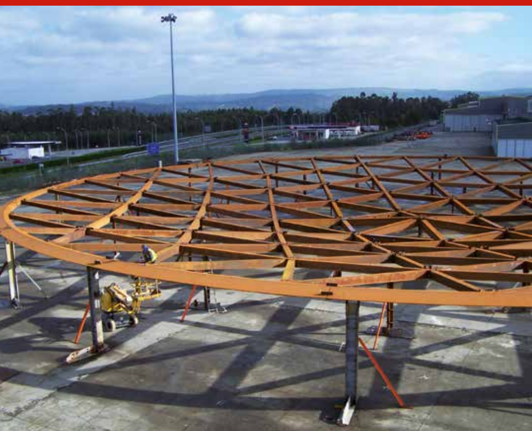
Test di assemblaggio della copertura della Place Rogier a Bruxelles © XDGA - Xaveer De Geyter Architects / foto © Emesa, Coruña, Spain
